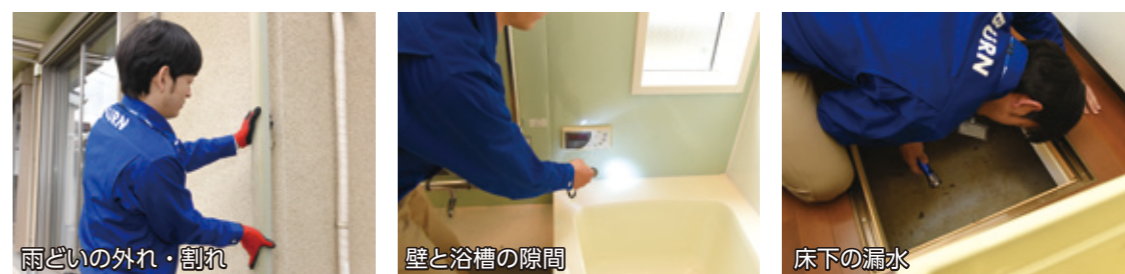
写真は2年点検で行う作業です。
